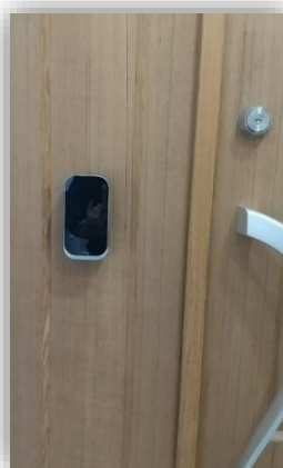
入室時(扉の外側)
