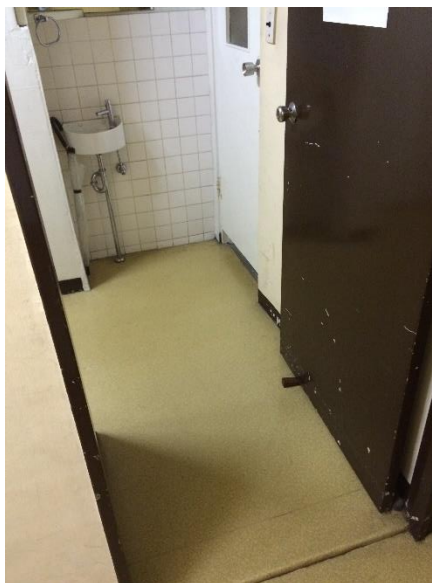
【2階】クランク後の幅73cm。奥左が当室で、右はトイレです
